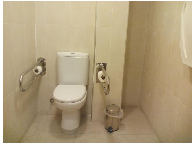
Aseo zona común adaptado
