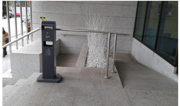
Rampa de acceso
